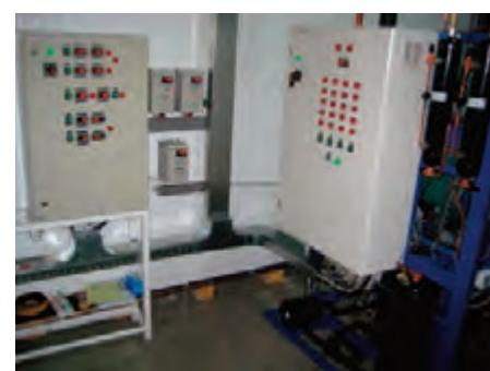
**Рисунок 1. Внешний вид щитов управления и трех частотных преобразователей системы хладоснабжения**
