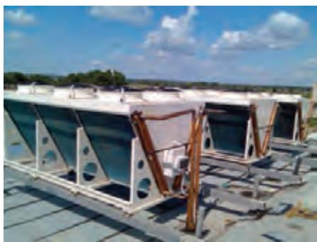
**Рисунок 2. Конденсаторы с адиабатической системой охлаждения**
